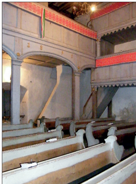
27. Angle gauche du fond de la nef avec les trois tribunes en quinconce et les différents escaliers d'accès
