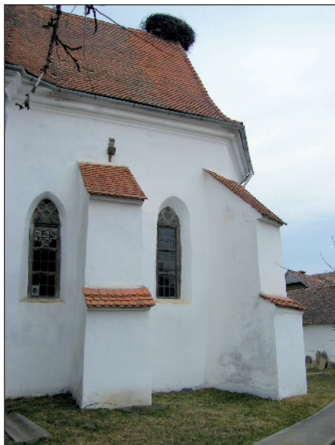
25. Les deux fenêtres ogivales du mur méridional du chevet. Seul le remplage supérieur subsiste
