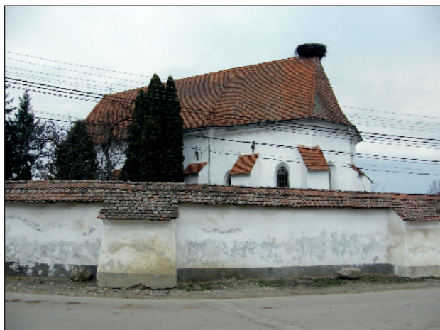
24. Vue sud-est du bâtiment compact de l'église, sans tour attenante, et de son enceinte soutenue par des contreforts
